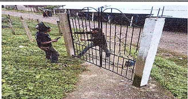
Foto 5: SUSTITUCION Y REHABILITACION DE MALLAS EN CIRCULACION EN TODO LA EXTENSION.
