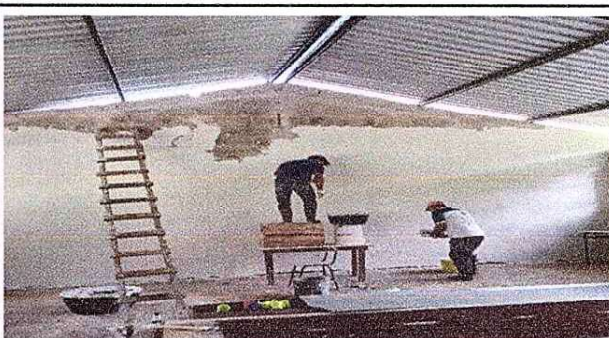
Foto 4: REPELLO DE PAREDES DE CADA AULAS.
