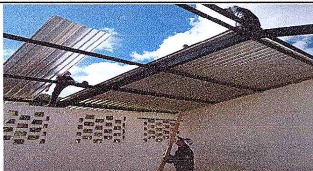
Foto1: SUSTITUCION DE CAMBIO DE LAMINAS EN AULAS
